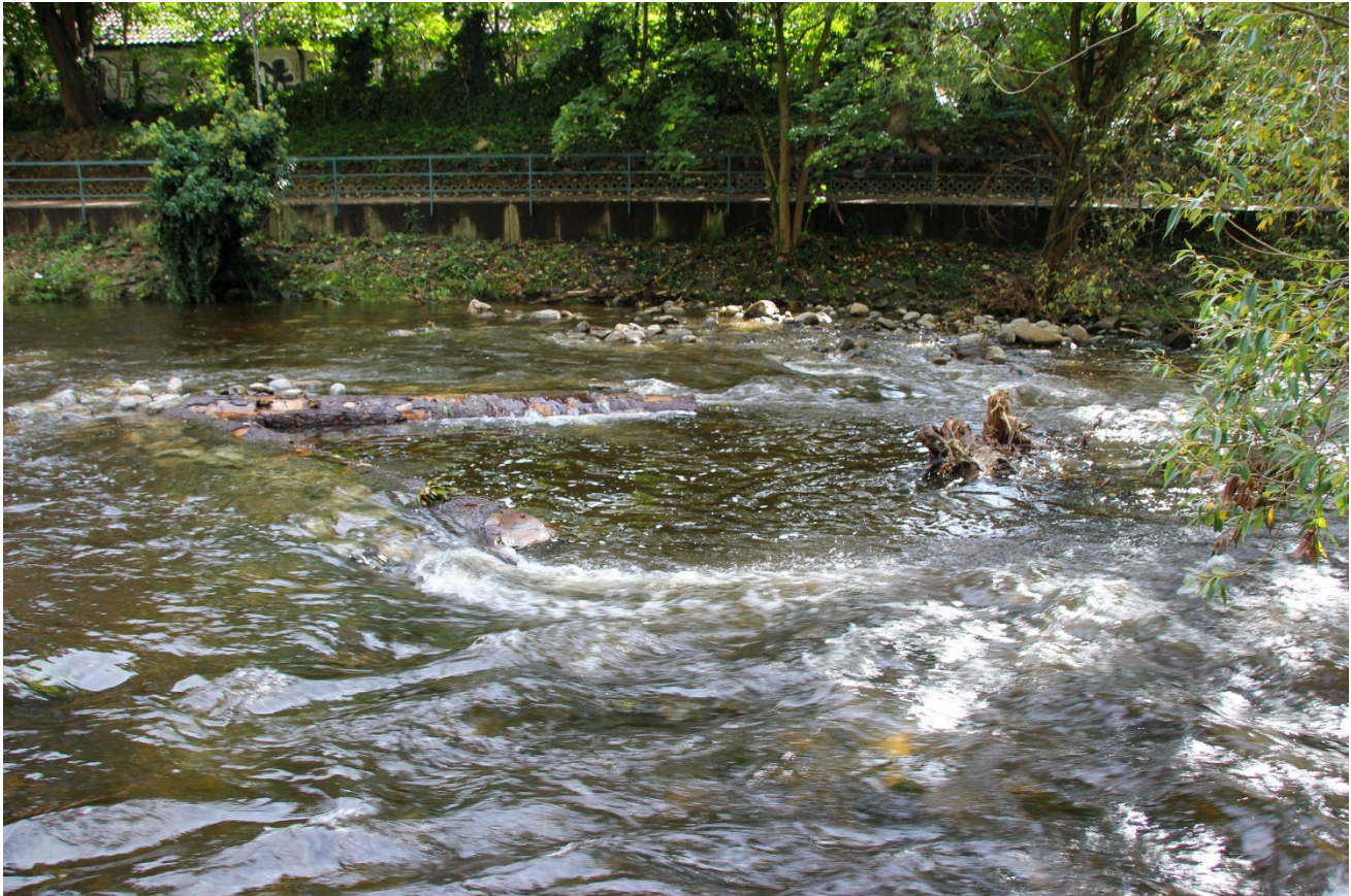
V-Buhnen schaffen strömungsberuhigte Bereiche und leisten einen Beitrag zur Revitalisierung der Dreisam, Foto: IG Dreisam e.V.
